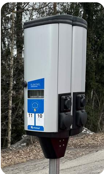
Elektra Design A5 pylväsasennus selät vastakkain
